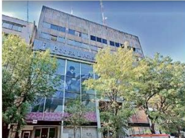
El edificio del Poder Legislativo, ubicado en Juárez y Ramón Corona, fue impermeabilizado con producto defectuoso.
