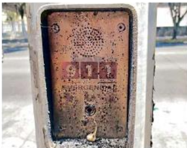
■ En menos de 5 meses han sido vandalizados 180 postes del C5.
