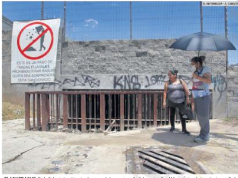
TLAQUEPAQUE. En la Colonia Las Huertas hay uno de los puntos añadidos este año al Mapa Único de Inundaciones. En la imagen, vecinos de la zona ven un canal que resulta insuficiente durante las lluvias.
