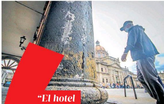
Los pilares de los arcos muestran grietas y fisuras. /FRANCISCO RODRÍGUEZ
