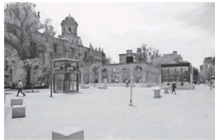
En observación continua la vía subterránea de la Línea 3. /FRANCISCO RODRÍGUEZ
