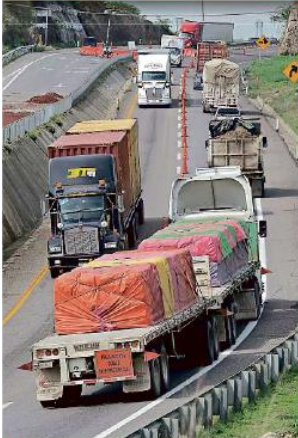
El tramo de 19 kilómetros, cuya ampliación está estancada, provoca lentitud en la circulación debido a tráileres.
