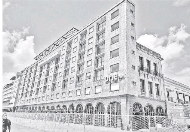
El inmueble por el momento se encuentre con vallas para evitar que la gente esté cerca del edificio. ELIZABETH RÍOS
