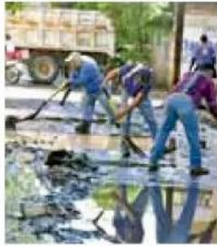
Trabajos. Aún hay labores de saneamiento. / CORTESÍA
