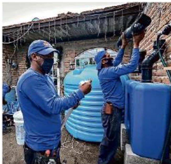
El Gobierno del Estado arrancó un programa piloto de captación de agua de lluvia denominado Nido de Lluvia.
