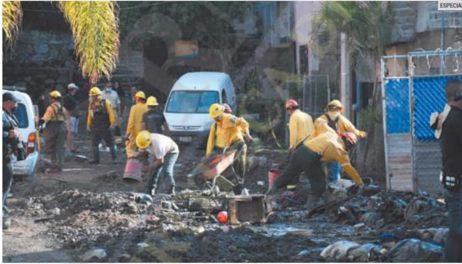
ESTRAGOS. Las inundaciones del fin de semana pasado dejaron afectaciones en 19 colonias.
