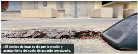
El desfase de losas se dio por la erosión y asentamiento del suelo, de acuerdo con experto.
