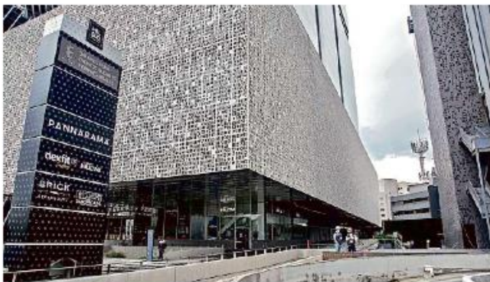
De acuerdo con los afectados, los extractores del edificio Mil500 dan hacia las oficinas.
