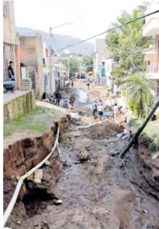
Comienza la demolición de fincas devastadas. /ANTONIO MIRAMONTES
