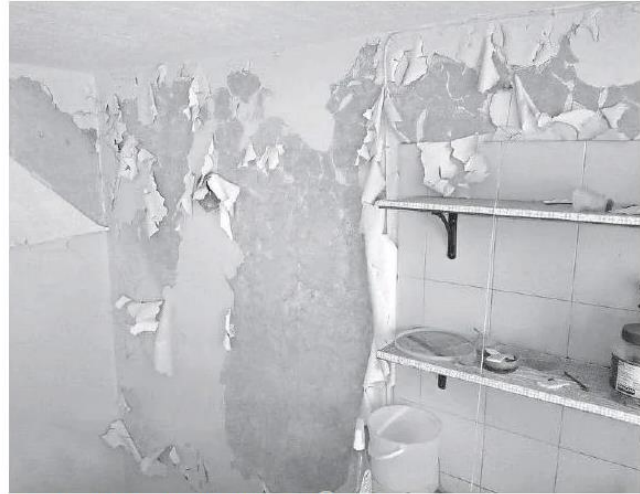
Los daños visibles a la estructura de la vivienda.
