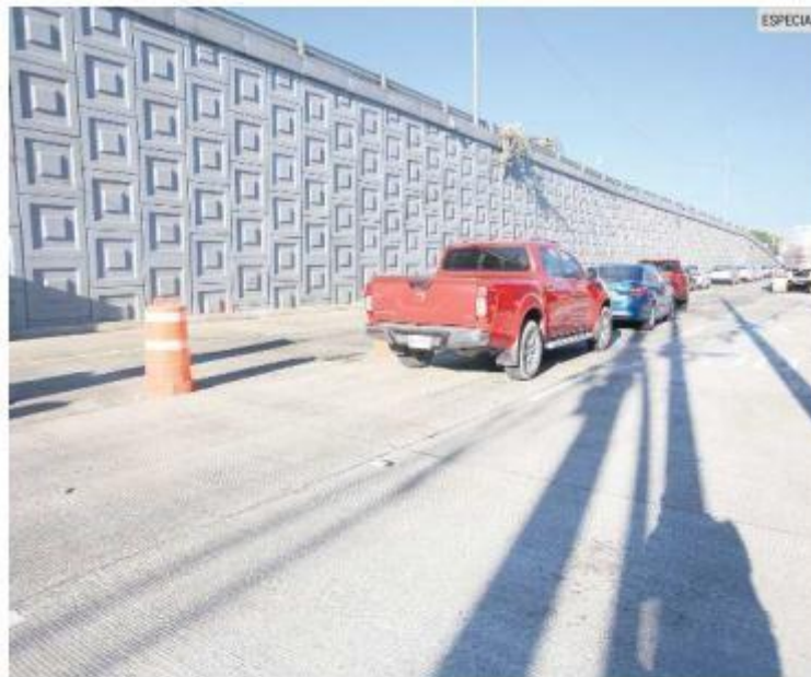
PAVIMENTO. Pablo Lemus afirma que el concreto hidráulico de los carriles tiene una durabilidad de 30 años.
