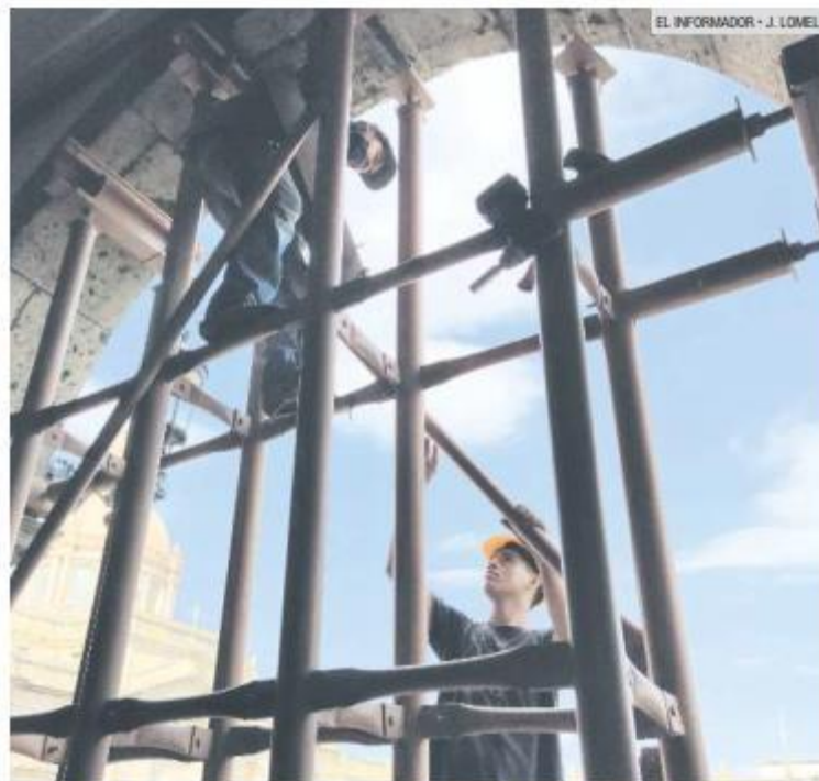
RAPIDEZ. El Gobierno tapatío indicó que a más tardar el lunes estarán retirados la mayoría de los puntales. Sólo quedarán algunos para reforzar columnas dañadas.
