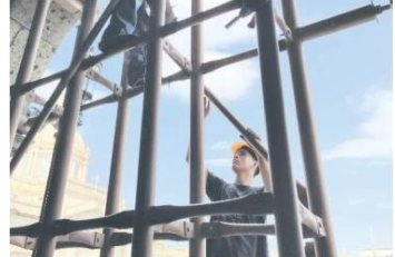
RAPIDEZ. El Gobierno tapatío indicó que a más tardar el lunes estarán retirados la mayoría de los puntales. Sólo quedarán algunos para reforzar columnas dañadas.
