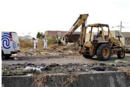
En la revisión fue utilizada una retroexcavadora.
