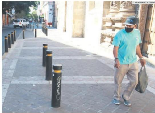
ESTORBAN. Ciudadanos se quejan de la mala distribución de los bolardos; en la calle de Santa Mónica colocaron tres piezas a la mitad de la banqueta, quitan espacio y representan riesgo para los peatones.
