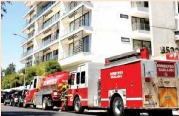
EN GDL. La explosión fue reportada en el segundo nivel del edificio de 14 pisos ubicado en Circuito Madrigal y Montevideo.
