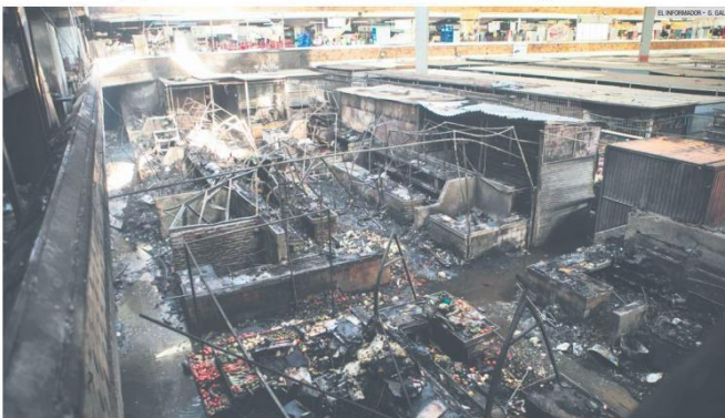
CAUSA. De forma preliminar, informan que una sobrecarga eléctrica pudo ocasionar el cortocircuito que derivó en el incendio.
