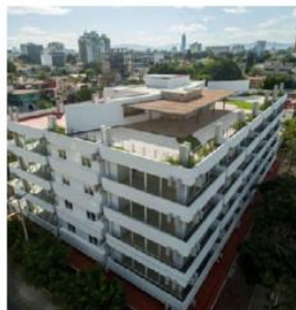
Edificio San Vicente, 1968.
