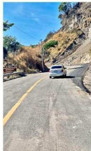
■ Los trabajos de rehabilitación de la carretera duraron seis meses.
