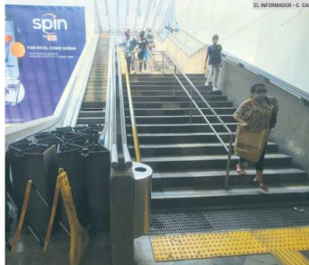
BLOQUEADO. En la estación Plaza Patria colocaron obstáculos para impedir que pasen los pasajeros; no hay fecha para la reparación.
