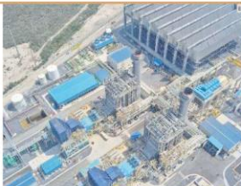
NUEVO LEÓN. La central de ciclo combinado de El Carmen genera electricidad para la industria; en Jalisco se potenciaría al sector.
