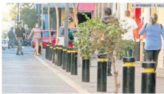
REGULADOS. Ya hay lineamientos para la instalación ordenada de bollards.
