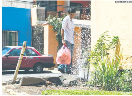
DESPERDICIO. Manuel González, vecino del Fraccionamiento Valle de Atemajac, se quejó porque en medio de los cortes de agua que aplicó el SIAPA en la ZMG, en este punto de la ciudad hubo una fuga que tardó horas en ser reparada.
