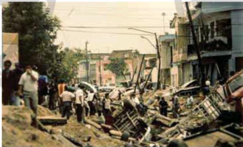
Origen. El sistema de alcantarillado acumuló gasolina. / PUBLIMETRO GUADALAJARA
