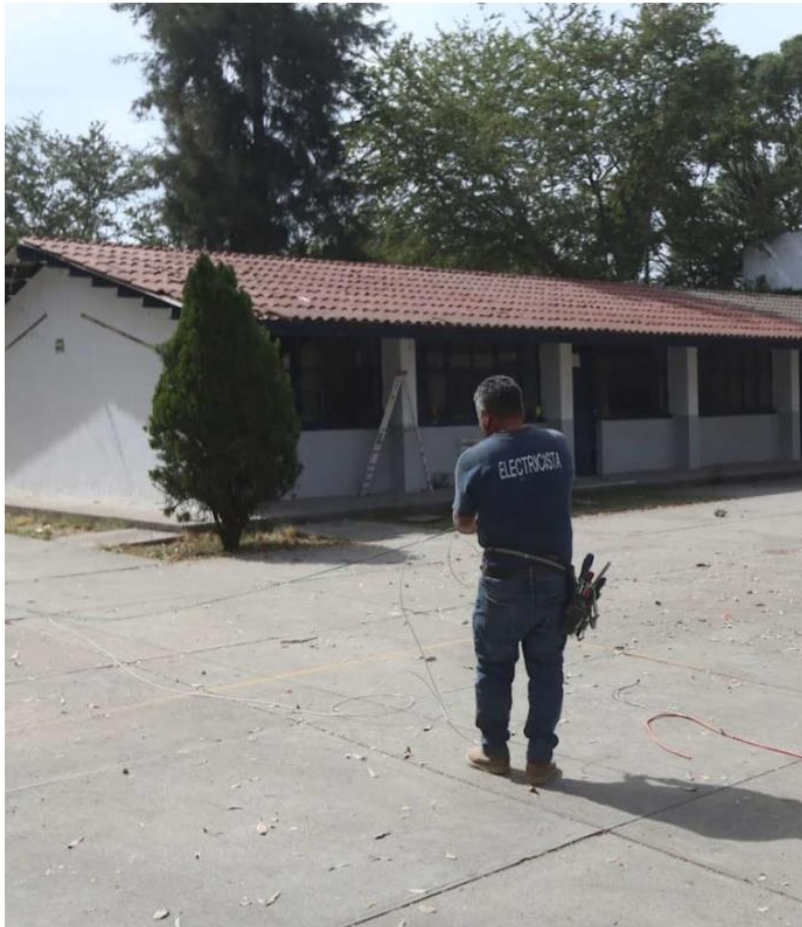
Los trabajos se realizarán durante el periodo vacacional. FERNANDO CARRANZA
