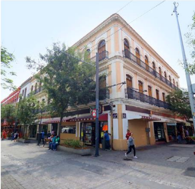
Para esta primera etapa se contempla la intervención de 8 fincas históricas y de valor patrimonial sobre Hidalgo. ESPECIAL
