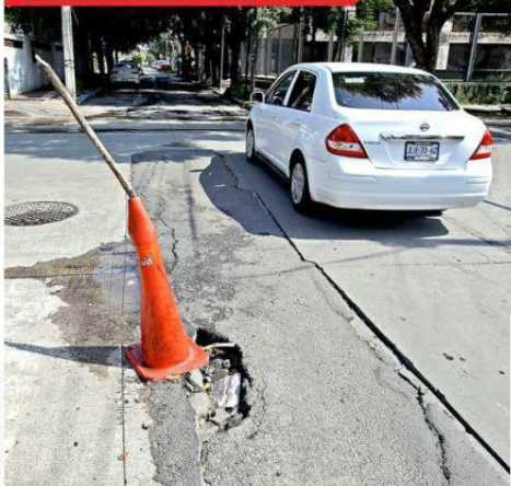
Lo que comenzó como un bache ya es hundimiento.
