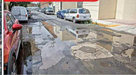
Los baches se juntaron y ya abarcan toda la calle.
