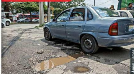
El asfalto ya desapareció y dio paso a un agujero.
