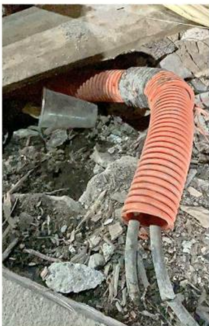
■ No se cuenta con ductos para proteger el cableado.
