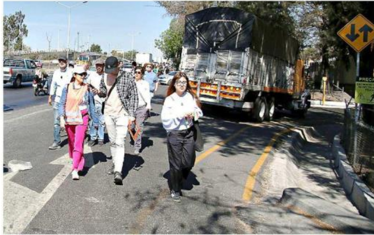
En algunos puntos, las banquetas casi desaparecen.
