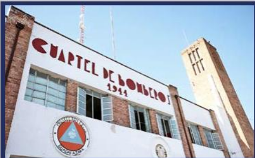
El alcalde tapatío Pablo Lemus encabezó un recorrido de supervisión por la primera etapa de intervención que se realiza en la Base 1 de Protección Civil y Bomberos.
