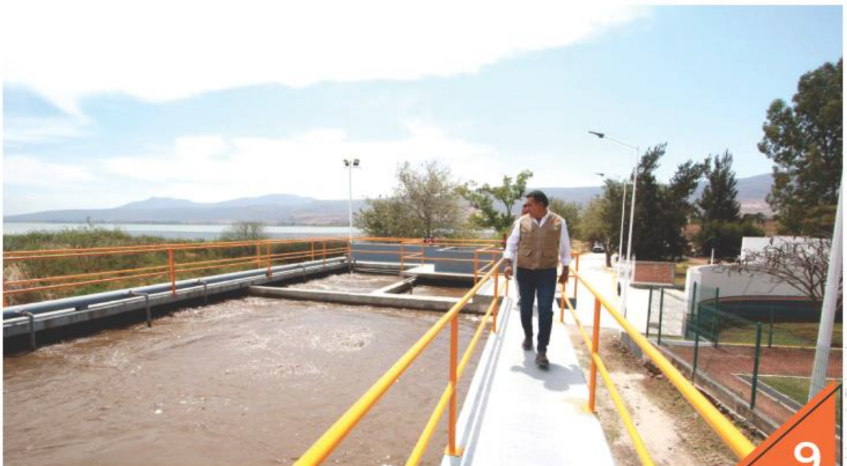
Salvador Zamora reveló que esta planta tiene una capacidad de 10 litros de agua por segundo.
