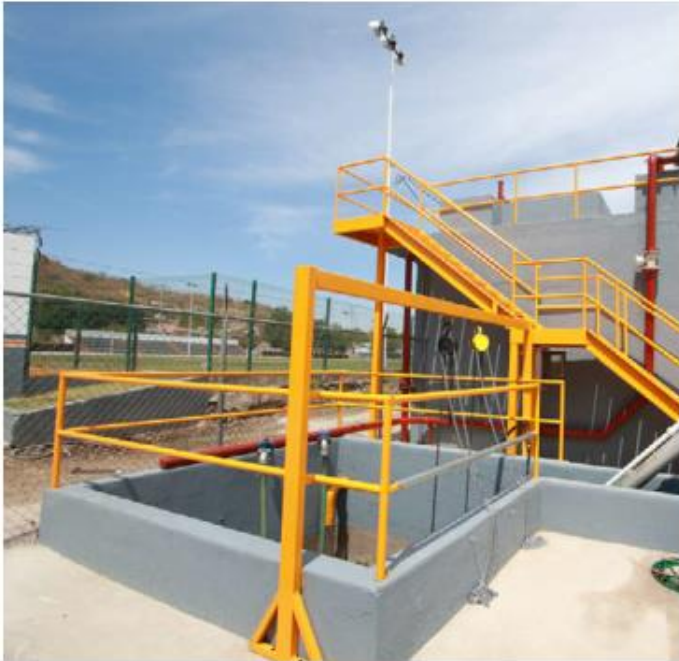
La rehabilitación de la planta de tratamiento tuvo una inversión de más de 3.5 millones de pesos. ESPECIAL
