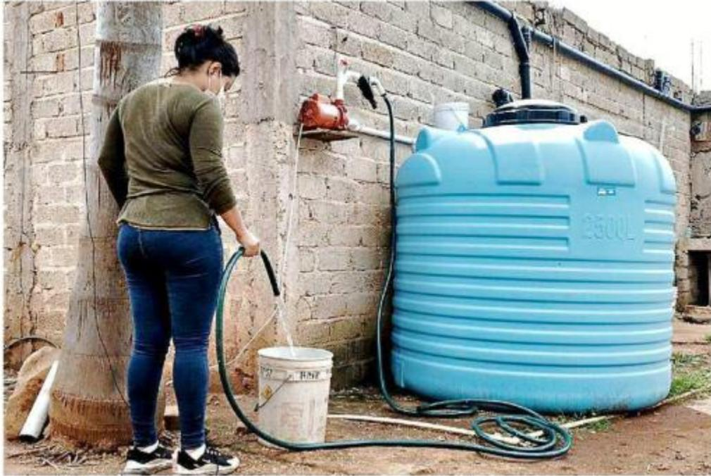
Los sistemas de captación constan de una cisterna para almacenar el agua.
