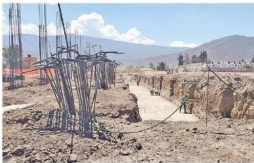
El nosocomio tendrá 5 niveles y se prevé quede listo en 2024.
