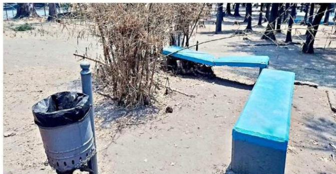
■ Hay bancas de concreto rotas, así como maleza seca.
