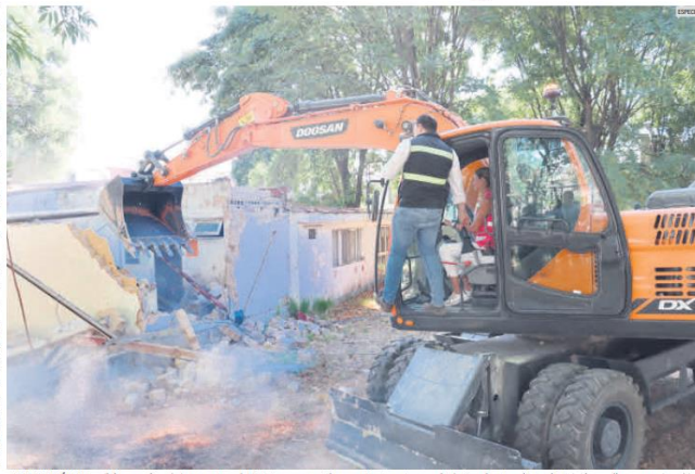
RENOVACIÓN. Demolición y mejora de la estructura del DIF Zapopan, en Primavera Norte; este espacio dará mejor atención en instalaciones dignas para la población del municipio.
