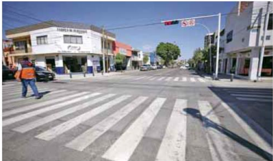
Ícono. La rehabilitación de la avenida arrancó el 2 de octubre de 2022. /CORTESÍA
