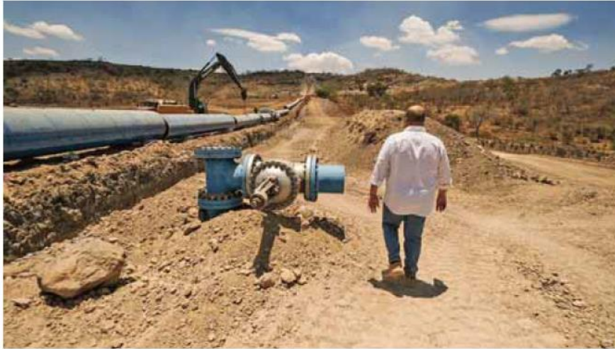
Inspección. Alfaro reconoció al presidente Andrés Manuel López Obrador por el impulso a esta infraestructura. / CORTESÍA
