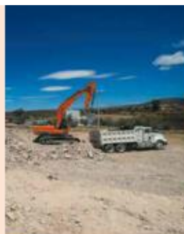
PRESAS. En la gira de ayer se supervisó el acueducto de El Salto hacia La Red y Calderón.
