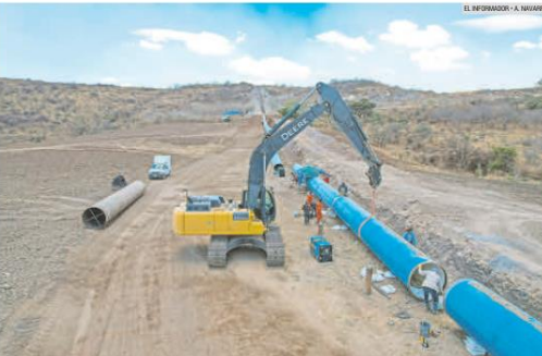
OBRAS. Este medio estuvo ayer en Valle de Guadalupe, municipio en donde el Gobierno federal trabaja en el acueducto que traerá más agua para la Zona Metropolitana de Guadalajara (ZMG). Se espera que esté listo en diciembre de este año.
