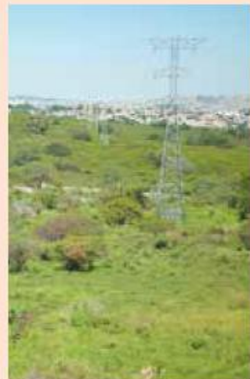
PROYECTO. En la zona se llevan a cabo obras de la avenida Troncal.
