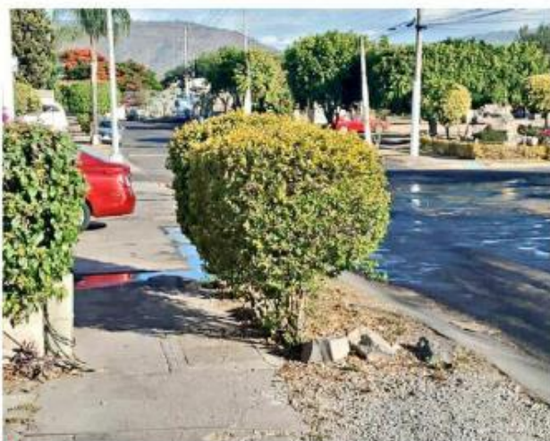
■ Mientras fraccionamientos no tienen agua, ayer había una fuga en la Avenida Guardia Nacional, en El Fortín.
