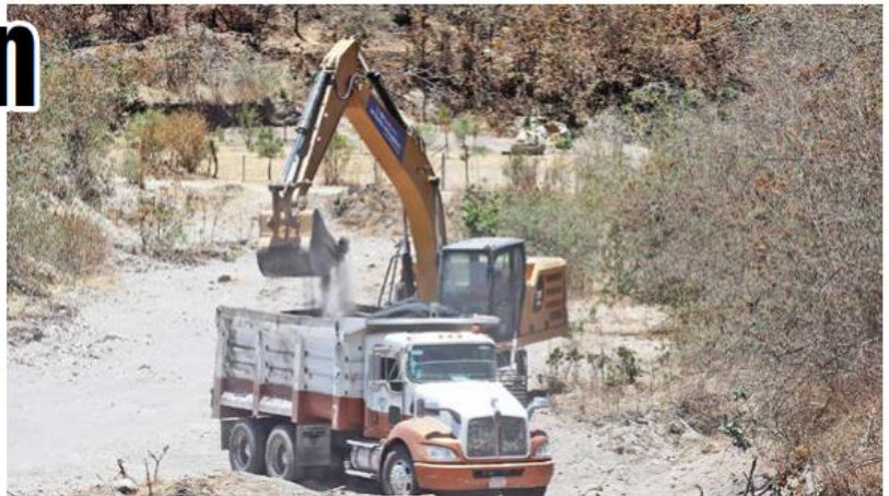
Entre las principales obras destacan las presas de gaviones.
