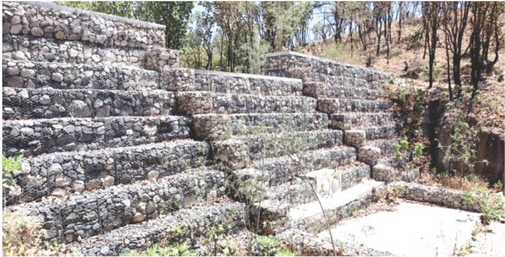
Los gaviones son estructuras de piedras comprimidas por mallas enrejadas de hierro galvanizado,
