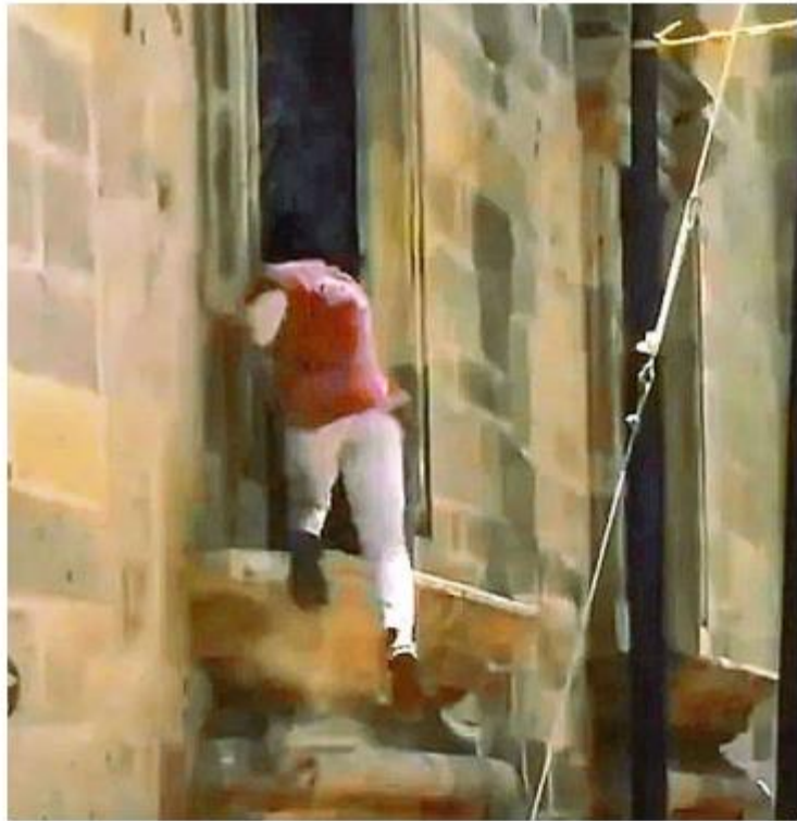
En redes sociales fue captado el joven influencer cuando derribó parte de la estructura del edificio. ESPECIAL
