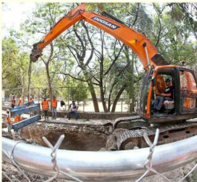
En la zona se construye un colector pluvial.
