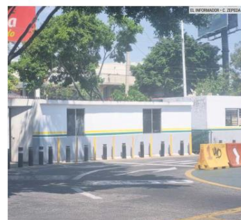
"BLINDAJE". El Gobierno estatal puso bolardos de los más caros en las oficinas de la Setran, ubicadas en Alcalde y Circunvalación, para proteger una pared.
