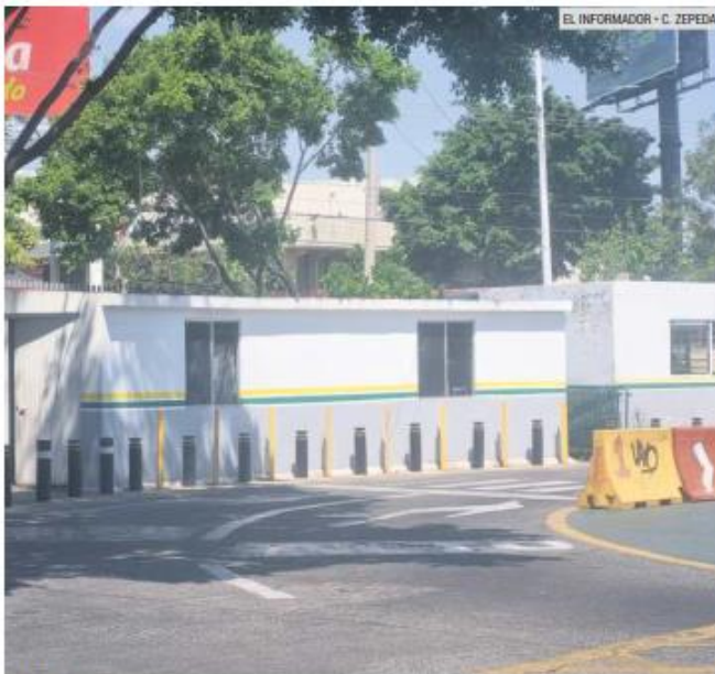
"BLINDAJE". El Gobierno estatal puso bolardos de los más caros en las oficinas de la Setran, ubicadas en Alcalde y Circunvalación, para proteger una pared.
