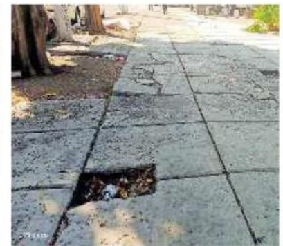
También hay bancas en mal estado.
