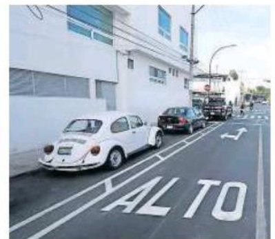
La inversión en obra pública ha sido la más alta.
