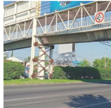
Van a retirar un puente peatonal para reconstruirlo.
