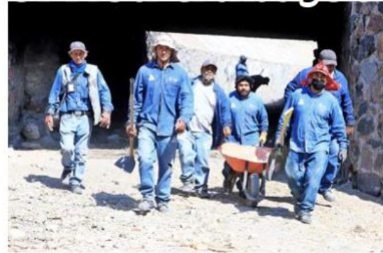
El desazolve en cauces y bocas de tormenta en el municipio comenzó en abril.
