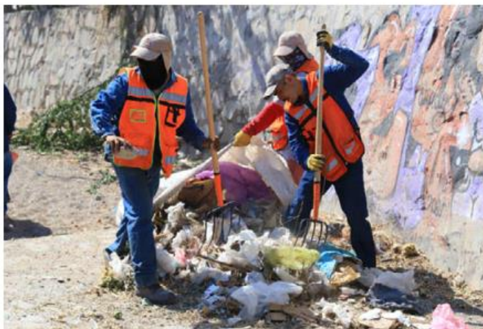
TEMPORAL. Cuadrillas del gobierno de Zapopan trabajan en el desazolve de canales y cuencas en distintos puntos del municipio como parte de las acciones para mitigar las inundaciones.
