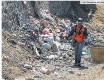
LABOR. El personal del Ayuntamiento de Zapopan trabaja desde hace semanas en la limpieza de los canales para evitar afectaciones a la población.
