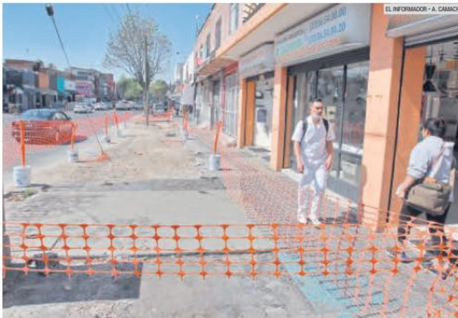
CICLOVÍA. Los trabajos de remodelación en Avenida Javier Mina comenzaron en enero pasado.
