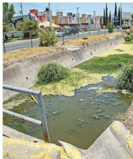
■ Así luce el canal pluvial de Villas de la Hacienda.
