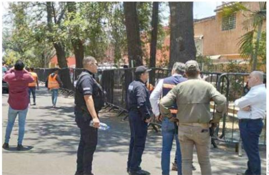
En la zona se está instalando un colector de agua.
