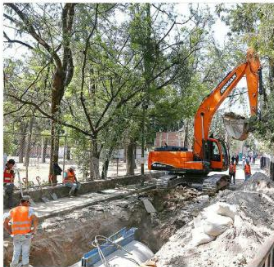
En la zona del Parque San Rafael se construyó un colector.
