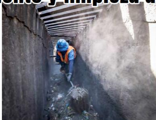
El total de azolve extraído es de 81,330.81 de metros cúbicos.
