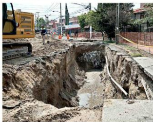
Por la ruptura de dos colectores corrió agua, lo que arrastró la tierra y dejó sin soporte el pavimento, que colapsó.
