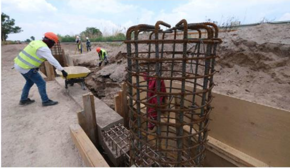
Los trabajos se realizan en tiempo y forma, de acuerdo con las autoridades. ESPECIAL
