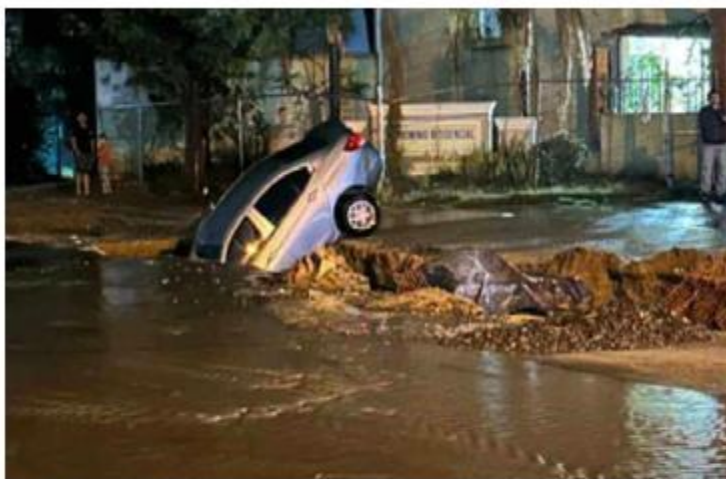
DESPLOME. Un vehículo cayó al interior de un socavón ubicado en el andador Riva Palacio, en el fraccionamiento Rinconada del Parque, en Tonalá. El agujero se generó debido a algunas obras.
