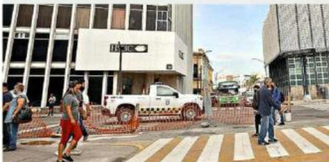
■ Se iniciará con trabajos preliminares.
