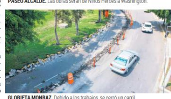
GLORIETA MONRAZ. Debido a los trabajos, se cerró un carril.
