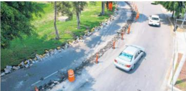
GLORIETA MONRAZ. Debido a los trabajos, se cerró un carril.
