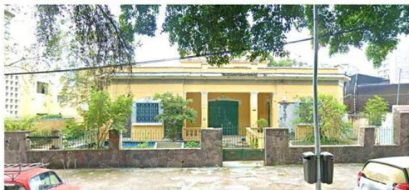
Esta fue la casa sobre José Guadalupe Zuno que fue demolida por disposición del Tribunal de Justicia Administrativa y aval del Ayuntamiento.
