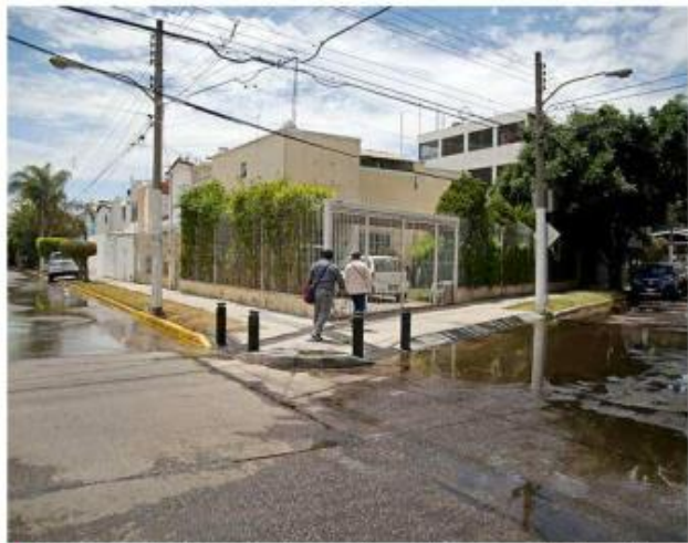
■ El Siapa recibe 48 reportes por fugas de agua potable al día y afirma que tarda en promedio dos días en atender.
