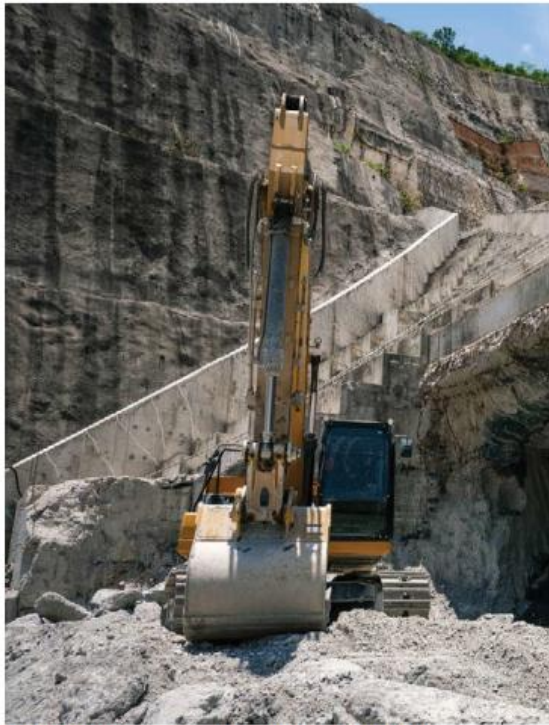
Los trabajos avanzan en tiempo y forma. ESPECIAL
