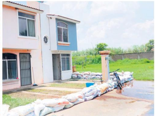
COMO SE PUEDA. En Villa Fontana, ubicada en San Pedro Tlaquepaque, tratan de prevenirse ante la posibilidad de nuevas inundaciones en dicho fraccionamiento.
