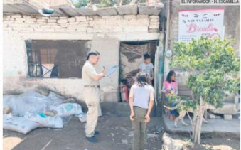
DAÑOS PATRIMONIALES. La intensidad de las lluvias de la semana pasada dejaron afectaciones en el menaje de viviendas en Tlaquepaque.
